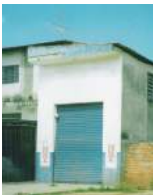
Local interditado por funcionar sem a presença de um farmacêutico responsável e sem licença de funcionamento.
