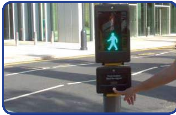
Figura 48 - Semáforo para pedestres com acionamento manual
