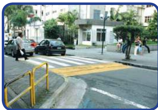
Figura 28 - Faixa elevada na esquina da quadra
