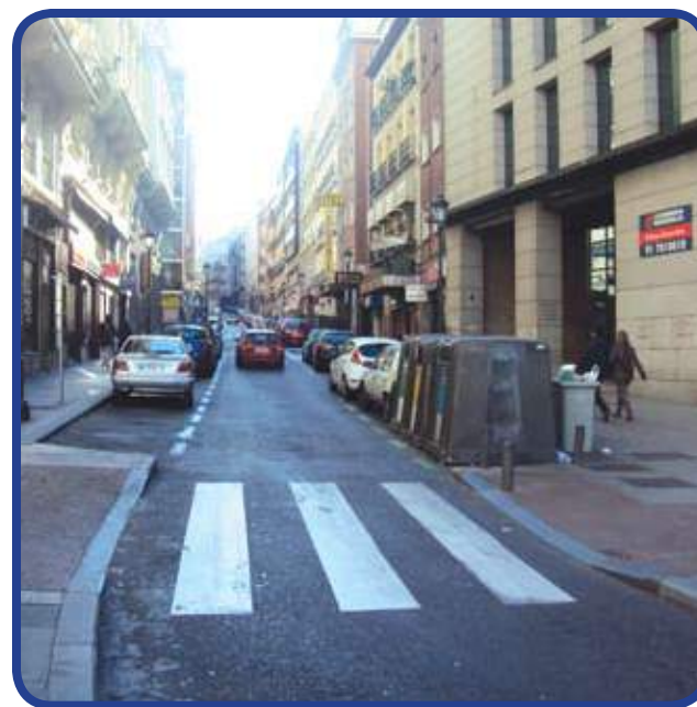
Figura 26 - Avanço da calçada
