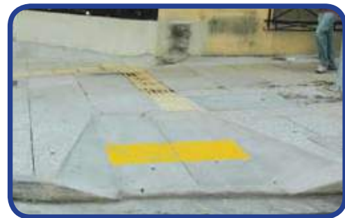
Figura 20 - Rebaixamento – exemplo A
