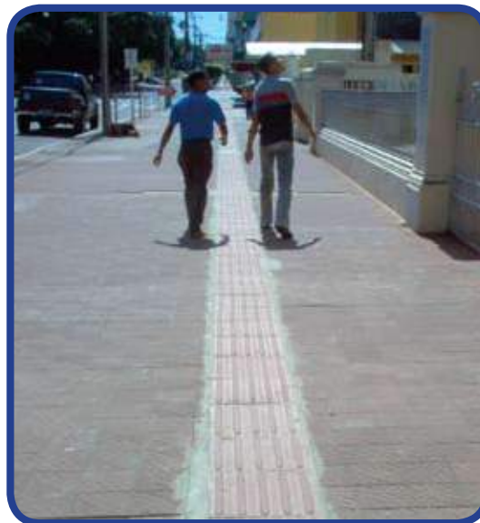
Figura 38 - Piso tátil direcional na calçada
