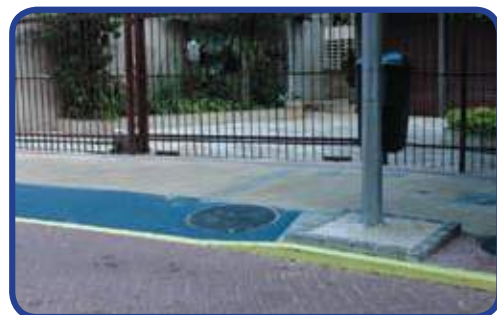
Figura 19 - Rampa na faixa de serviços para entrada de veículos
