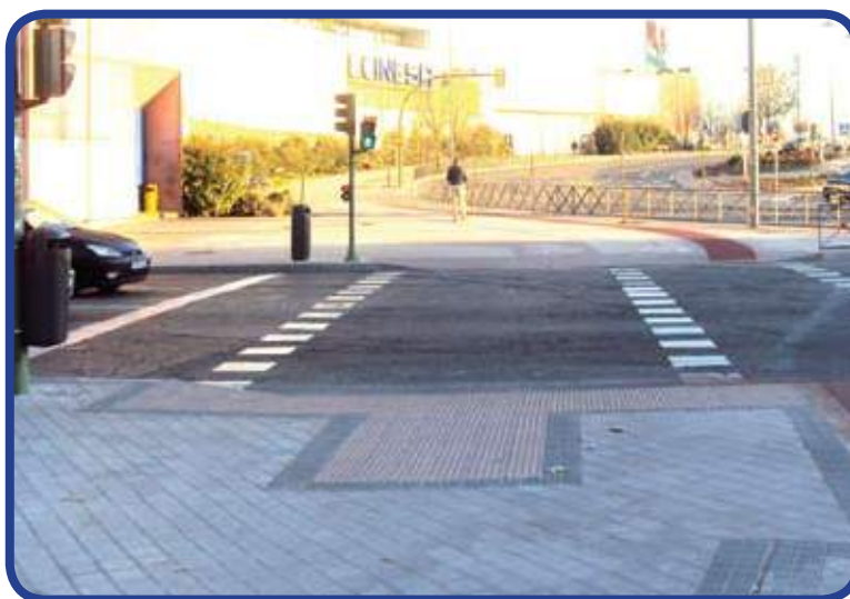
Figura 21 - Rebaixamento – exemplo B
