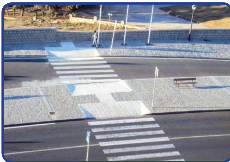
Figura 22 - Rebaixamento – exemplo C
